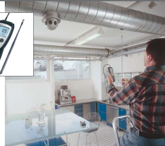
Medir velocidad en un conducto de ventilación. La sonda telescópica facilita la medición en puntos de difícil acceso
