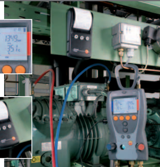
LLenado de refrigerante con el testo 523
