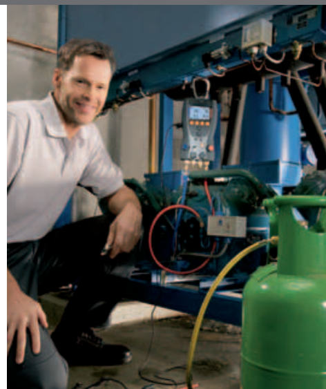
Llenado de un sistema de refrigeración con los testo 556 y 560
